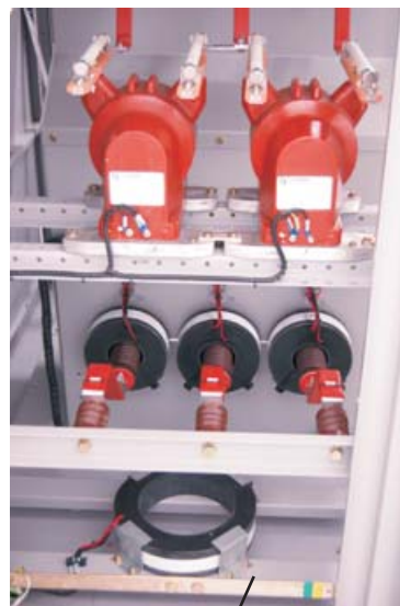
Traseira da parte fixa do módulo de controle extraível. Pode-se ver os TCs e TPs
